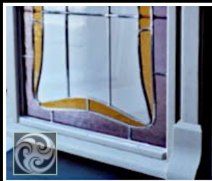
... und nach den Sanierungsmassnahmen
